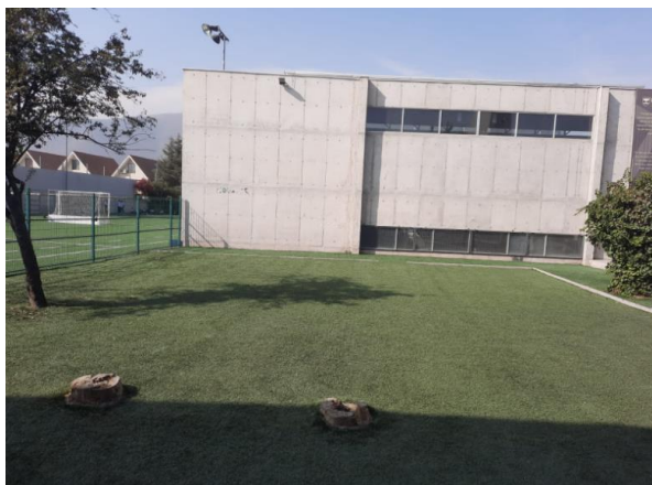
Zona de Seguridad Nº 1 PATIO LADO CANCHAS
